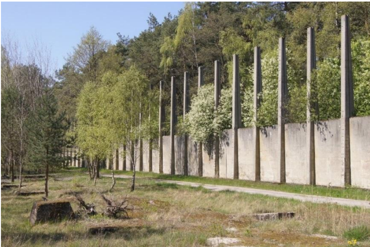
Zdj. 5 Teren dawnego poligonu w pobliżu dzisiejszego Bobolina – żelbetowy mur ochronny z miejscem na wstawianie desek.
